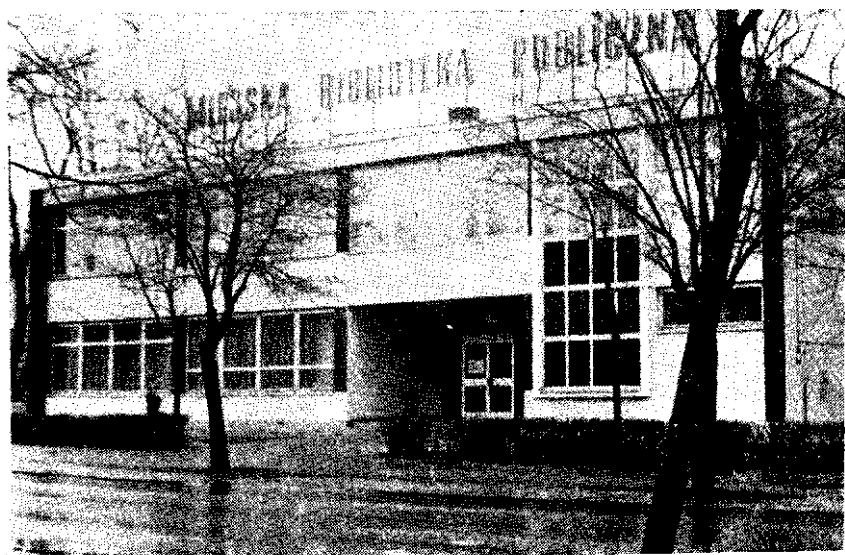
Budynek MBP w Czeladzi.
